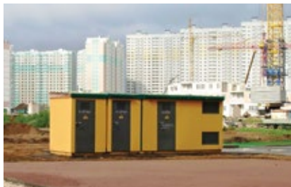
НА ФОТО: Ввод новых энергообъектов в г. Люберцы Московской области
