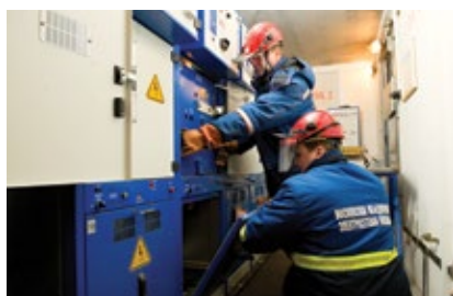
НА ФОТО: Наладка оборудования 20 кВ
