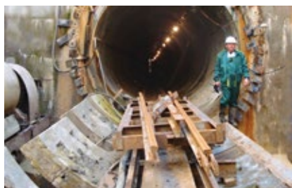
НА ФОТО: Прокладка кабельной линии
