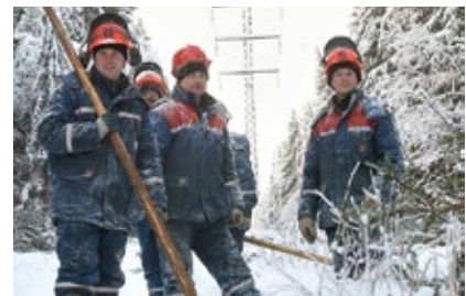
НА ФОТО: Восстановление электроснабжения после «леяного дождя»
